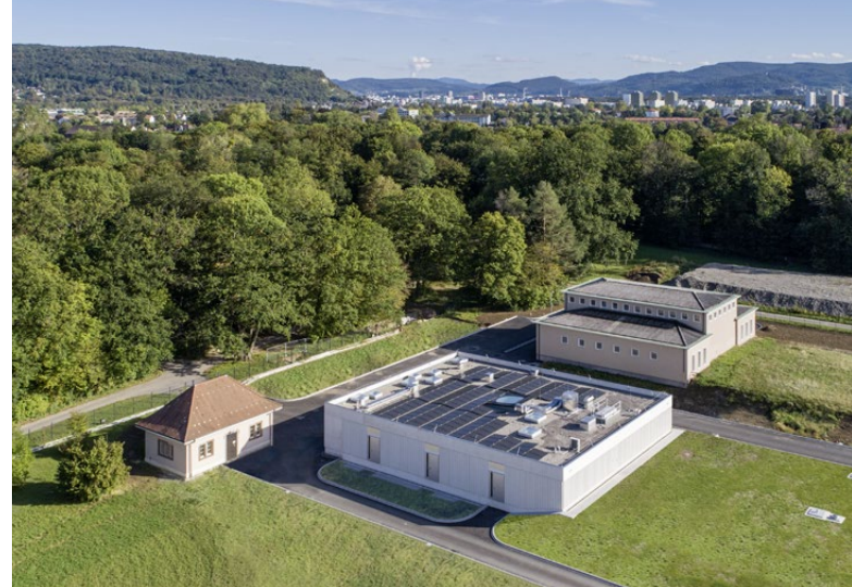
Die neue Pumpstation Lange Erlen mit PV-Anlage auf dem Dach
