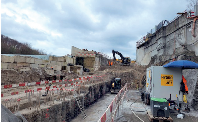
Blick auf die mehrstufige Baugrube der zukünftigen Fischtreppe
