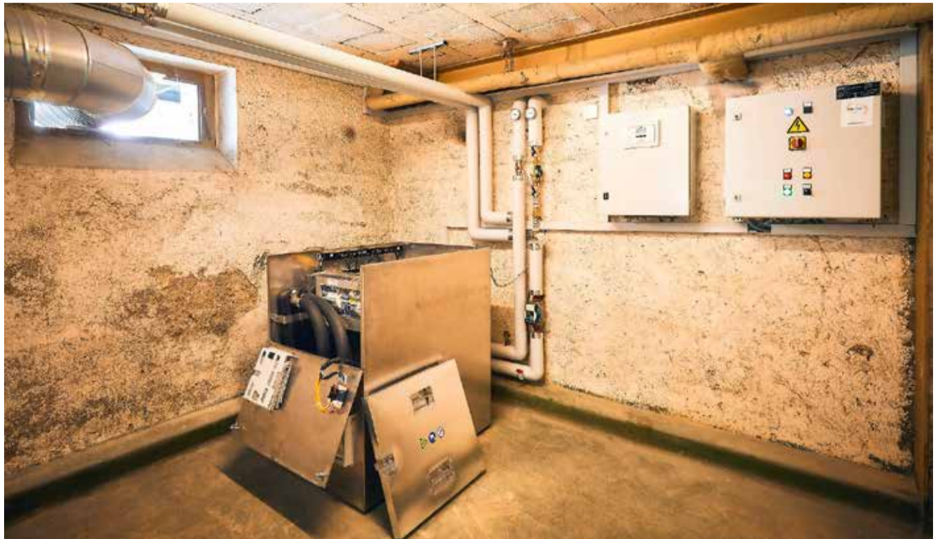
Die Digitalisierung heizt ein: Das Gehäuse (oben) bietet bis zu 12 Server-Blades (rechts) Platz. Deren Abwärme wird für Raumwärme und Warmwasser genutzt. BILDER IWB
