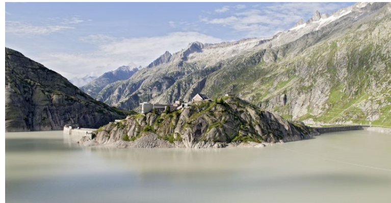
Der Grimselsee ist mit einem Volumen von 95 Mio. m 3 der grösste Speichersee im Grimselgebirge. Er wird von der Kraftwerke Oberhasli AG zur Stromerzeugung genutzt, an der IWB zu 16.7% beteiligt ist.
