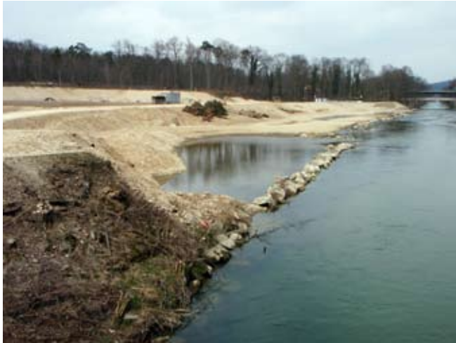
Das Ufer während der Bauarbeiten
