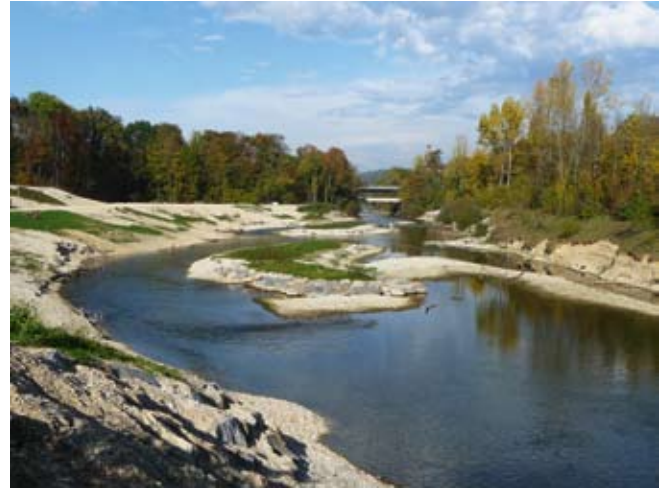
Nach Abschluss der Arbeiten: kiesige Flachwasserzonen und abgeflachte Uferböschungen haben die Birs für Mensch und Tier aufgewertet
