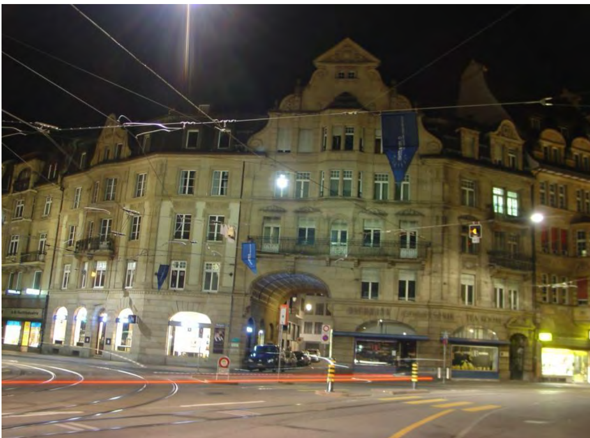
Fassade Marktgasse mit Anleuchtung (kombinierte Seilleuchte, Strassen- u. Fassadenbeleuchtung getrennt schaltbar)
