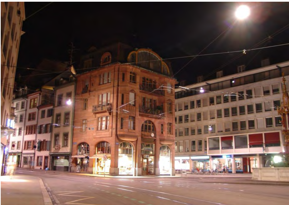
Fischmarkt 5 mit Anleuchtung (kombinierte Seilleuchte, Strassen- u. Fassadenbeleuchtung getrennt schaltbar)
