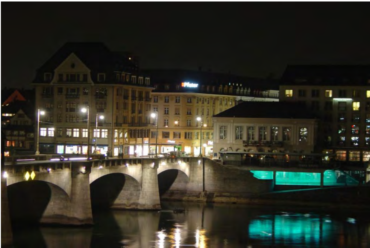
Basel, Mittlere Brücke, Brückenkopfgebäude ohne Anstrahlung
