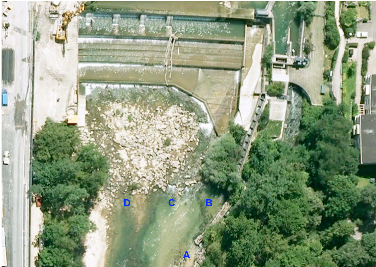
Abbildung 9: Kraftwerk Neuwelt mit Fischtreppe (Luftaufnahme aus Google Maps). A: Einstieg Fischtreppe; B: Auslauf Turbine; C, D: mögliche Hauptfliessrichtungen bei überströmtem Wehr und ausgeschalteter Turbine.
