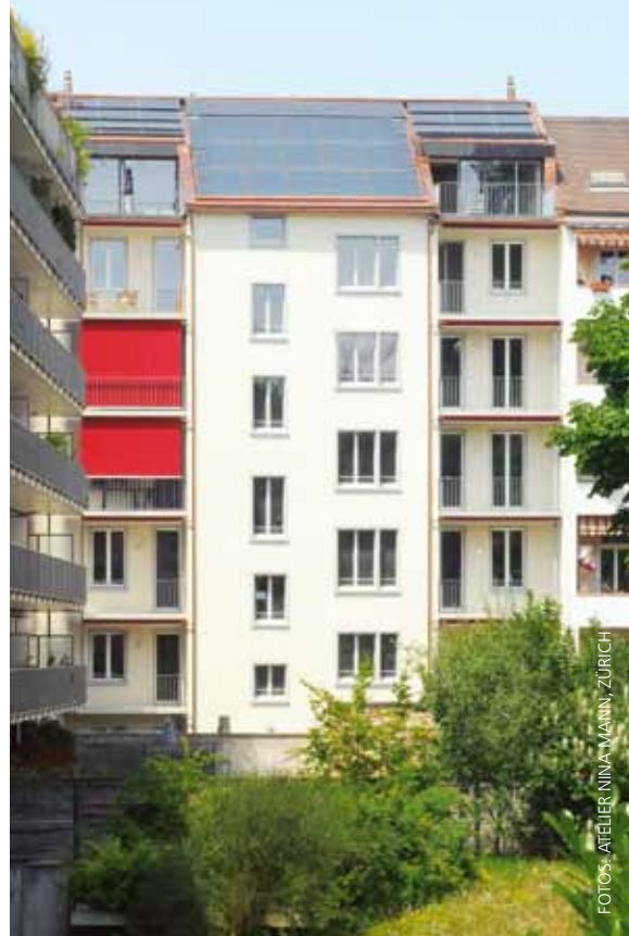
Die Rückansicht des Gebäudes: Auf dem Dach zu sehen, die Solar-Anlage zur Erzeugung von Strom und Wärme.
