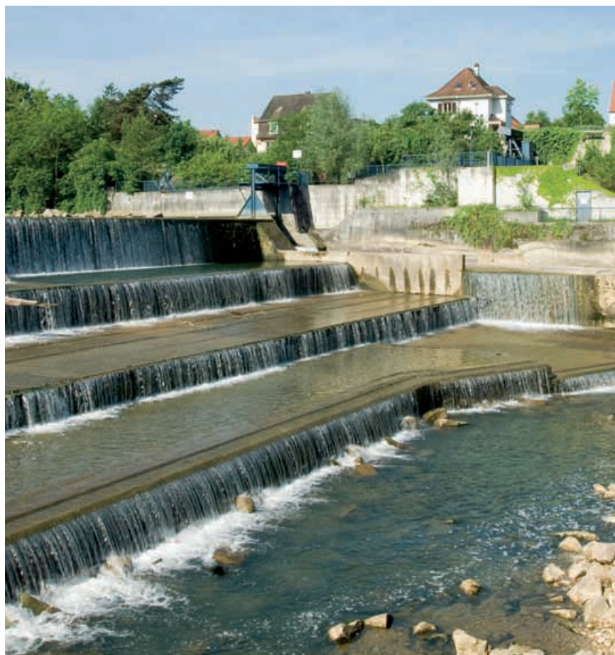
Am Wasserhausquartier gelegen, nutzen die IWB die natürliche Auswaschung in der Birs zur regionalen Ökostromproduktion.
