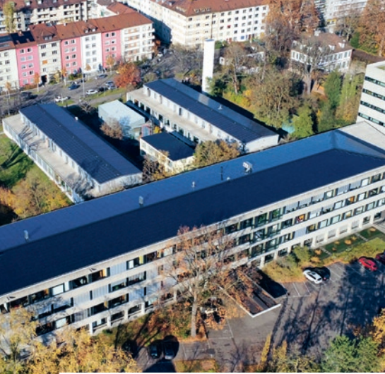
Die Indach-Photovoltaikanlage auf dem Verwaltungsgebäude der Allgemeinen Gewerbeschule Basel hat eine Leistung von 348 kWp.
