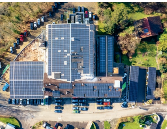
Bei SwissCo Services in Sisseln sind neben den Dächern auch die Carports mit PV-Paneln bestückt.
