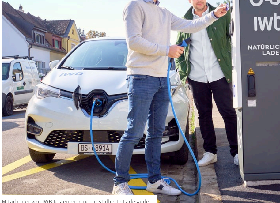
Mitarbeiter von IWB testen eine neu installierte Ladesäule.
